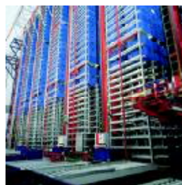
Moderní výškový sklad zabezpečuje účinnou logistiku
