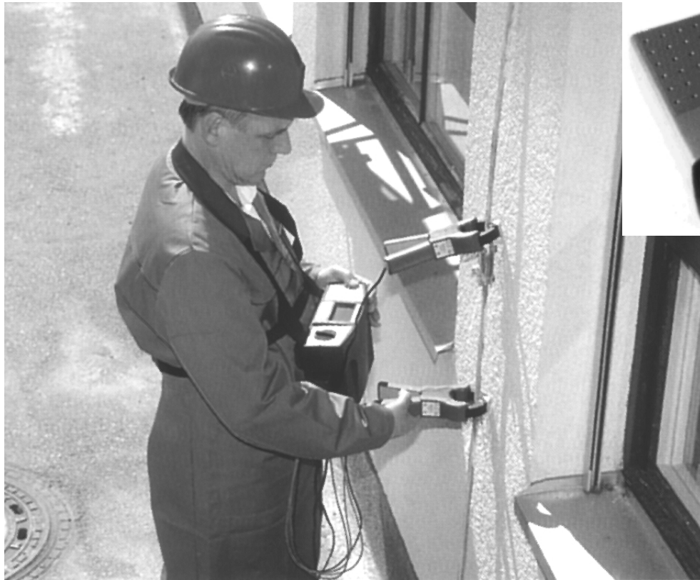
Měření zemního odporu bez rozpojení
